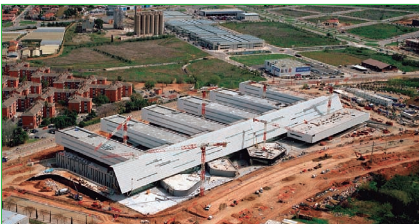
Imagen 2. Vista aérea del Hospital de ant Joan de Reus en construcción
