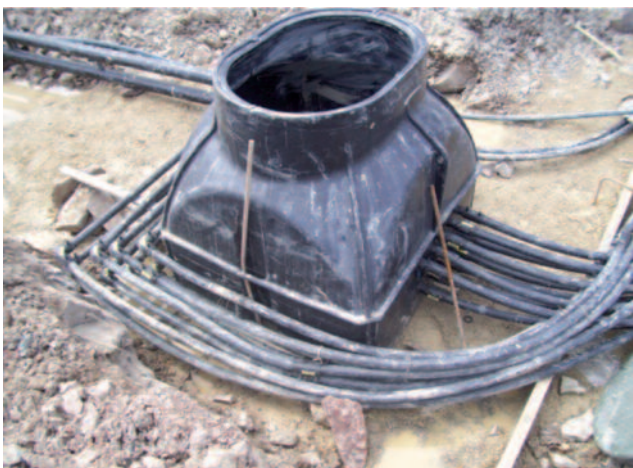
Foto de sondeos geotérmicos
