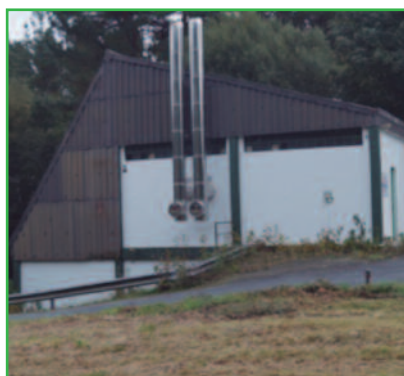
Hospital Calde. Central T. en antiguo edificio de Horno Incinerador.
