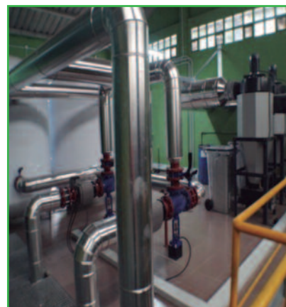
Depósitos de inercia y multiciclón.
