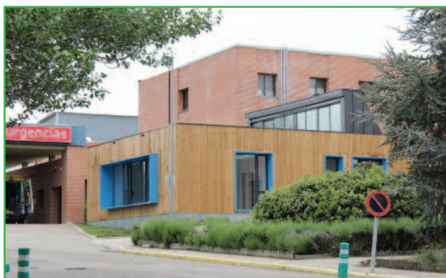
Imagen 1. El “pabellón Covid” anexo al hospital.
